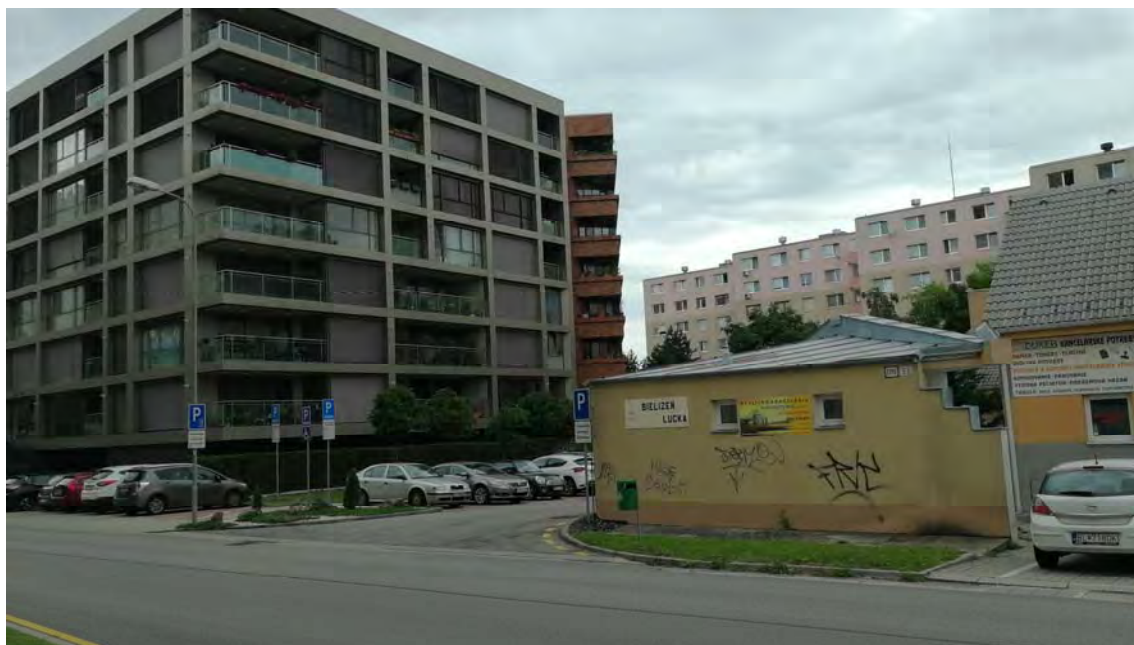
Obr. č. 4 – pohľad západný, jestvujúci stav
